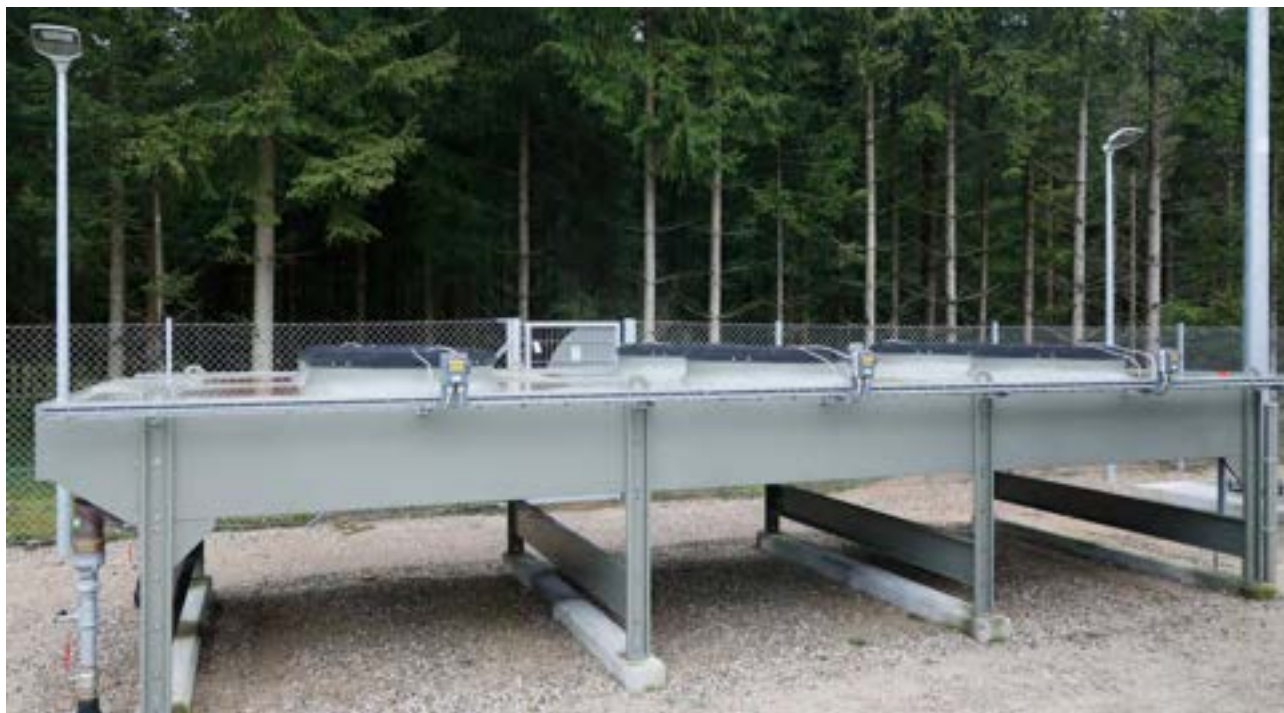
Foto nr. 02. Køler til kompressorer.
